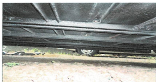
床下中央付近(右側から)
